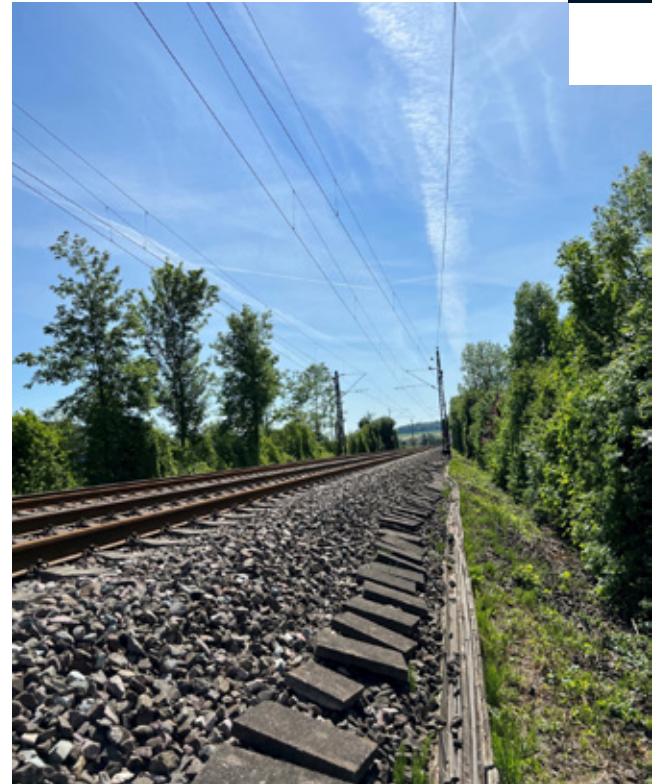
Abb. 15: Strecke mit offenem Kabeltrog während Bauarbeiten
