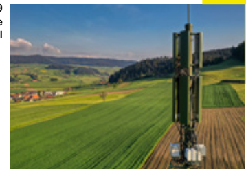
Abb. 9 Mobilfunk-Antenne im Emmental
