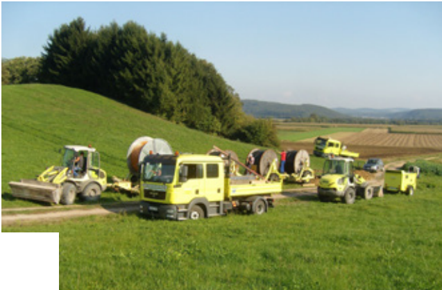
Abb. 11: Glasfaserausbau im Landkreis Waldshut
